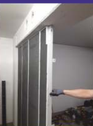
Ertüchtigung von Wänden durch Verwendung von Modulen nach EN 1143-1
