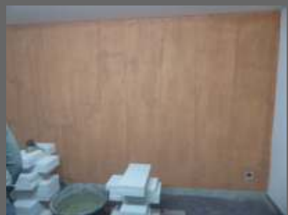
Ertüchtigung von Wänden durch Verwendung von Modulen nach EN 1143-1
