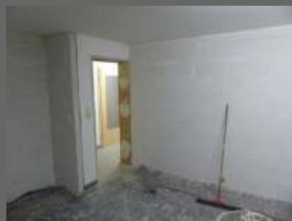
Ertüchtigung von Wänden durch Aufmauern
