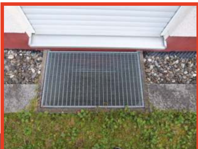
Ertüchtigung eines Kellerfenster Sicherungseinrichtung
