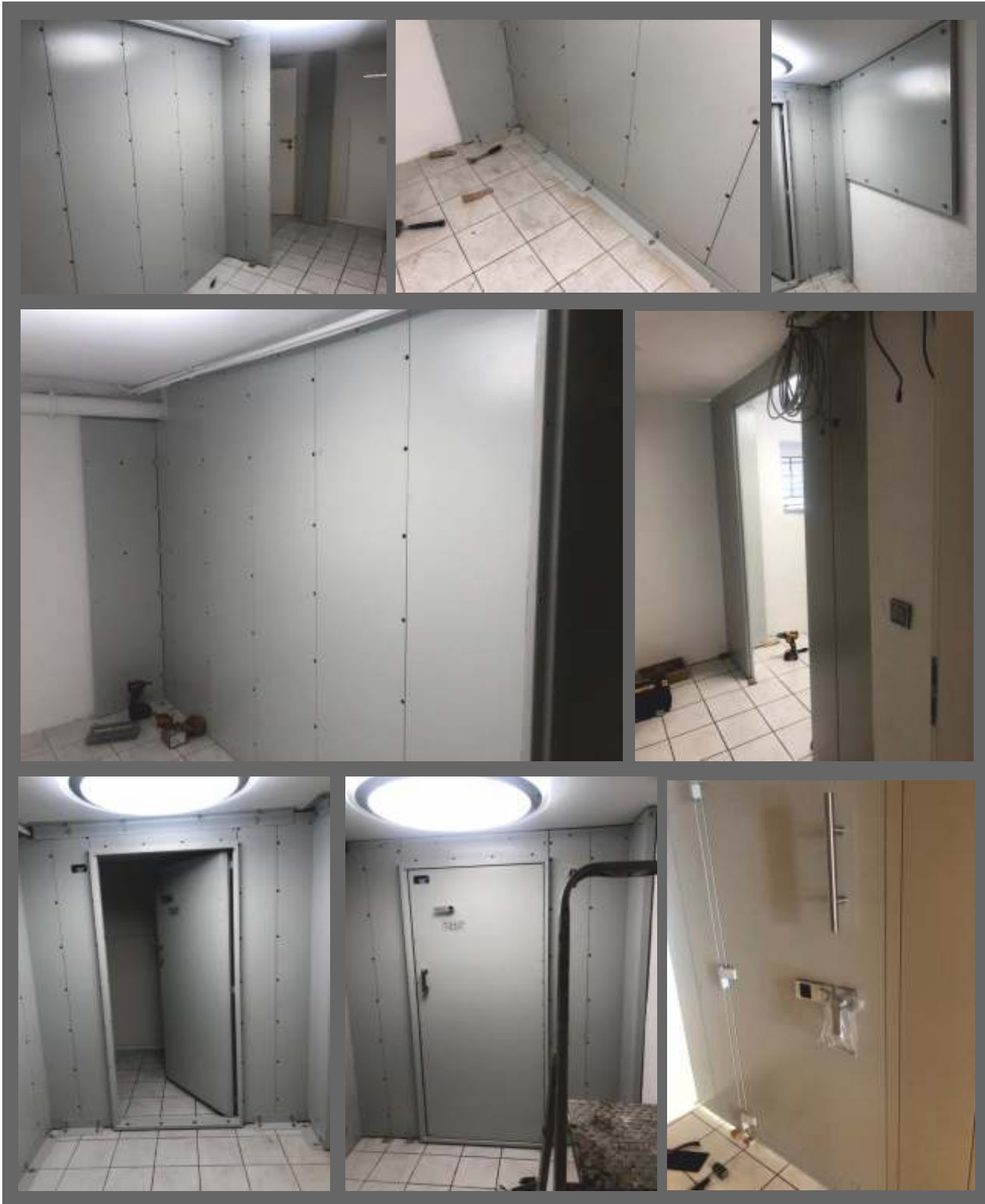
Erfolgte Ertüchtigung eines Kellerraumes Gleichwertig den Vorgaben nach Widerstandsgrad I (1) nach EN 1143-1 Euronorm Ausführung in 2022
