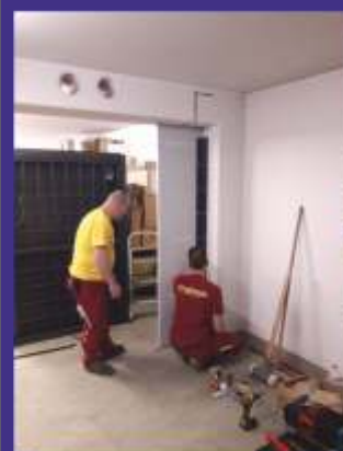
Ertüchtigung von Wänden durch Verwendung von Modulen nach EN 1143-1
