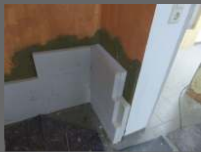
Ertüchtigung von Wänden durch Aufmauern
