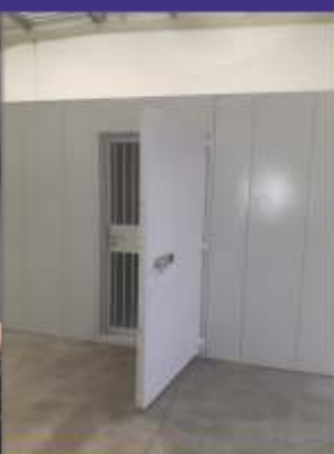
Ertüchtigung von Wänden durch Verwendung von Modulen nach EN 1143-1
