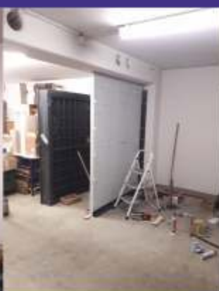
Ertüchtigung von Wänden durch Verwendung von Modulen nach EN 1143-1
